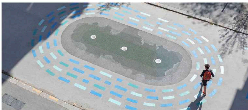
Aéro-Seine par Studio Idaï + BE Ogi. Ce terrain ludique, dessiné et coloré (Paris XX e ) lutte contre les îlots de chaleur : sur activation, une fine couche d'eau du canal de l'Ourcq et de la Seine s'écoule et imprègne un revêtement poreux (granulats minéraux Impact Systeme) qui rafraîchit l'air ambiant.
