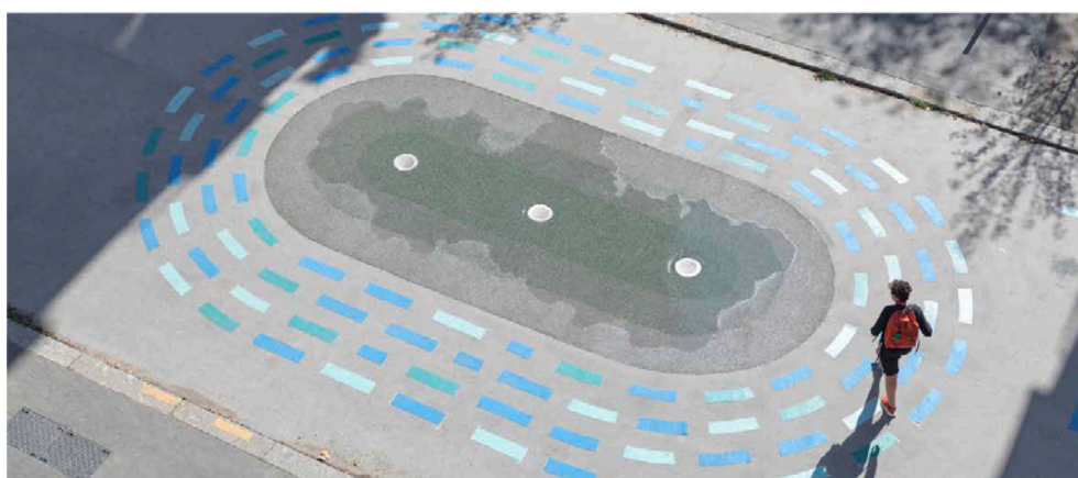
Aero-Seine par Studio Idaë + BE Ogi. Ce terrain ludique, dessiné et coloré (Paris XX e ) lutte contre les îlots de chaleur: sur activation, une fine couche d'eau du canal de l'Ourcq et de la Seine s'écoule et imprègne un revêtement poreux (granulats minéraux Impact Systeme) qui rafraîchit l'air ambiant.
